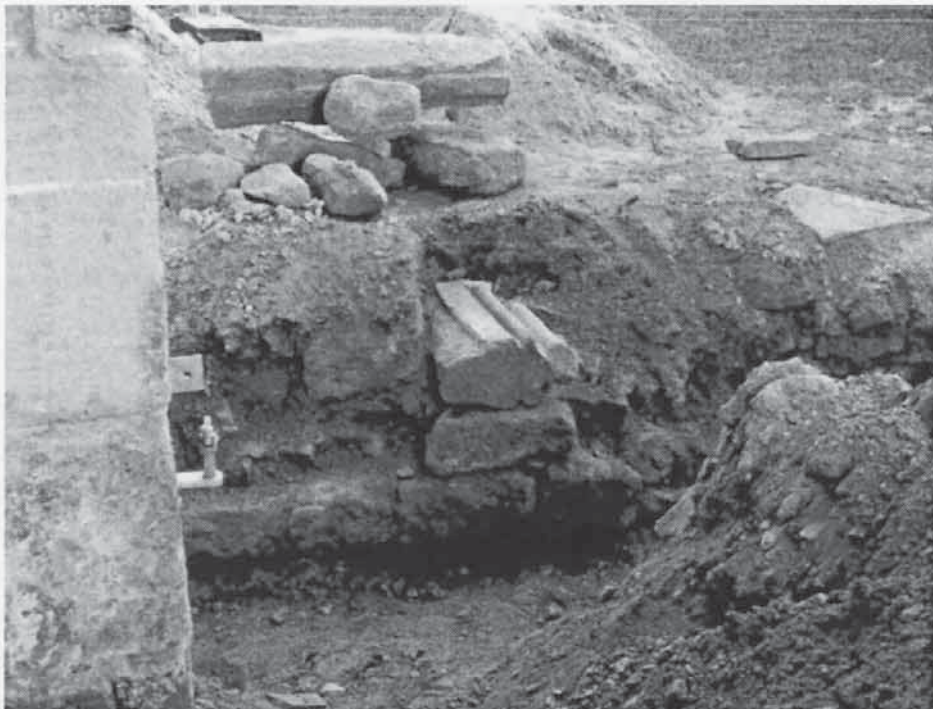
Abbildung oben: Nach dem Entfernen der Waschbetonplatten zeigt sich in etwa 20 cm Tiefe ein kunstvoll profiliertes Sandsteinfuß des Kirchturmpfeilers. Dieser lässt Rückschlüsse auf das alte Bodenniveau zu.
