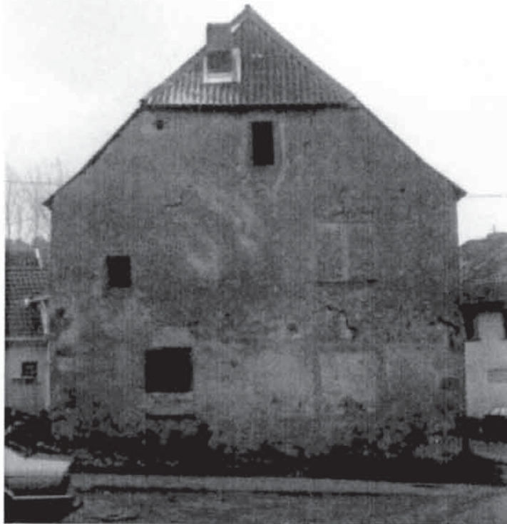
Abbildung oben: Nordgiebel mit zum Teil vermauerten Doppelfenstern
