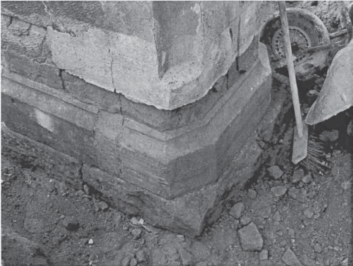
Abbildung oben: Nach dem Entfernen der Waschbetonplatten zeigt sich in etwa 20 cm Tiefe ein kunstvoll profiliertes Sandsteinfuß des Kirchturmpfeilers. Dieser lässt Rückschlüsse auf das alte Bodenniveau zu.
