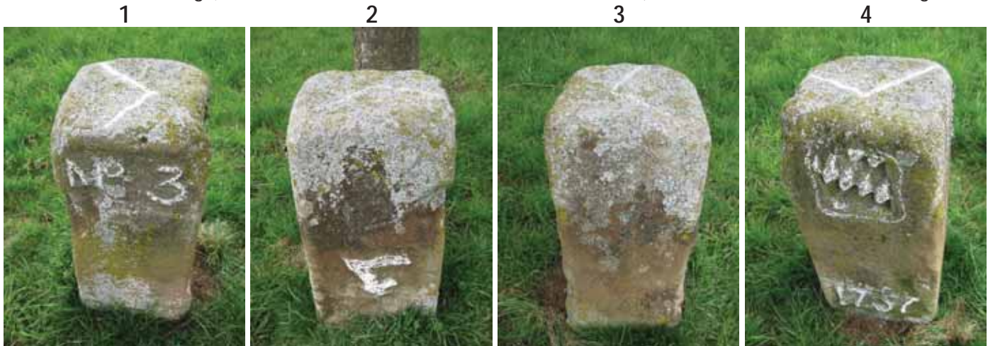
„N. S. 3“ = Nummer im Grenzzug Der Weiser auf dem Kopf zeigt fast im rechten Winkel nach links.
